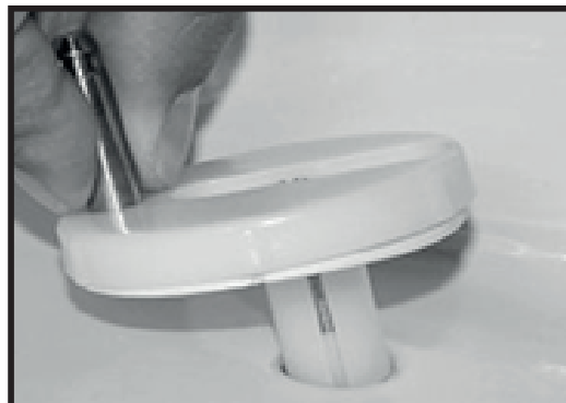
2. Coloque o parafuso no buraco de fixação.
