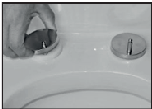
5. Coloque a tampa de aço inox sobre os parafusos.
